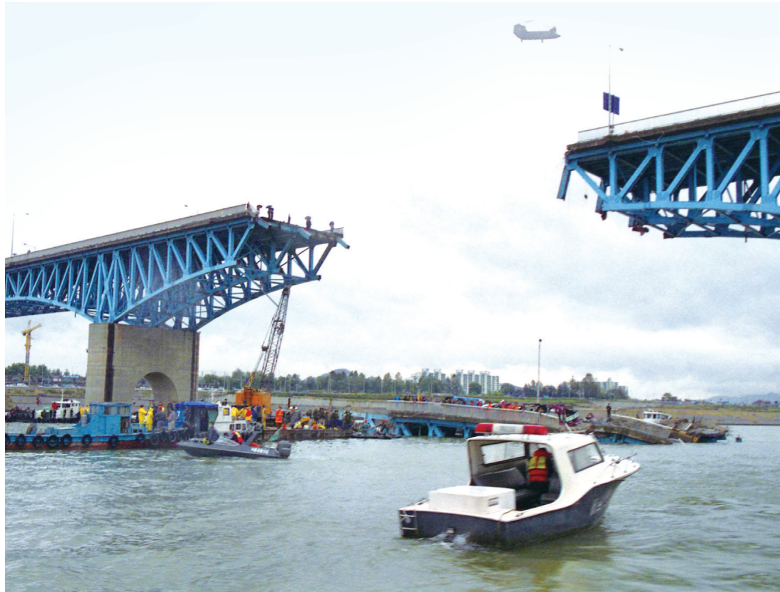
▲ <그림 1> 도시기반시설에 대한 유지보수를 게을리 한 결과물인 성수대교 붕괴사건
