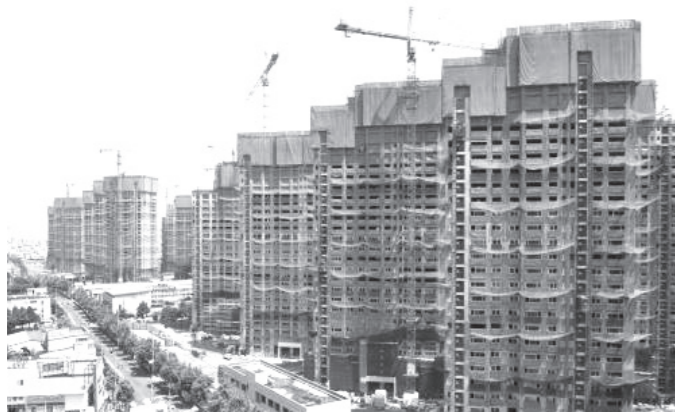
▲ 광주 U대회 선수촌 화정지구 재건축 현장
